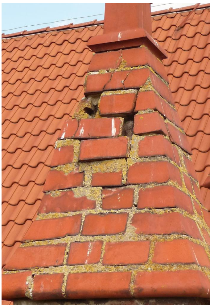
Widok fragmentu szczytu, prawdopodobne naprawy źle wykonane.
