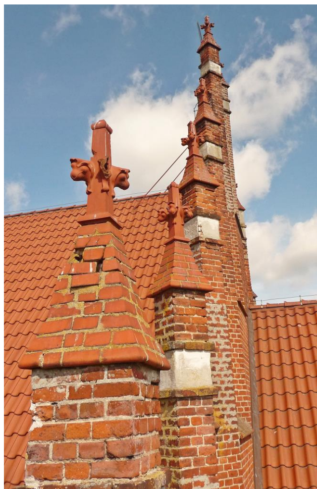
Widok fragmentu szczytu, prawdopodobne naprawy źle wykonane.
