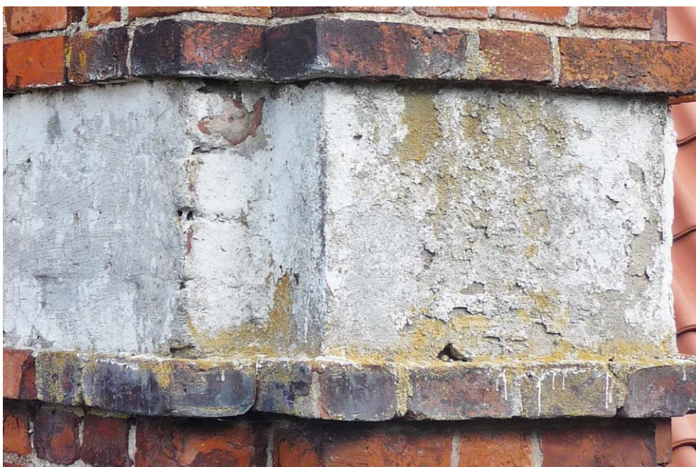
Widok sterczyny oraz zbliżenie wtórnego tynku.
