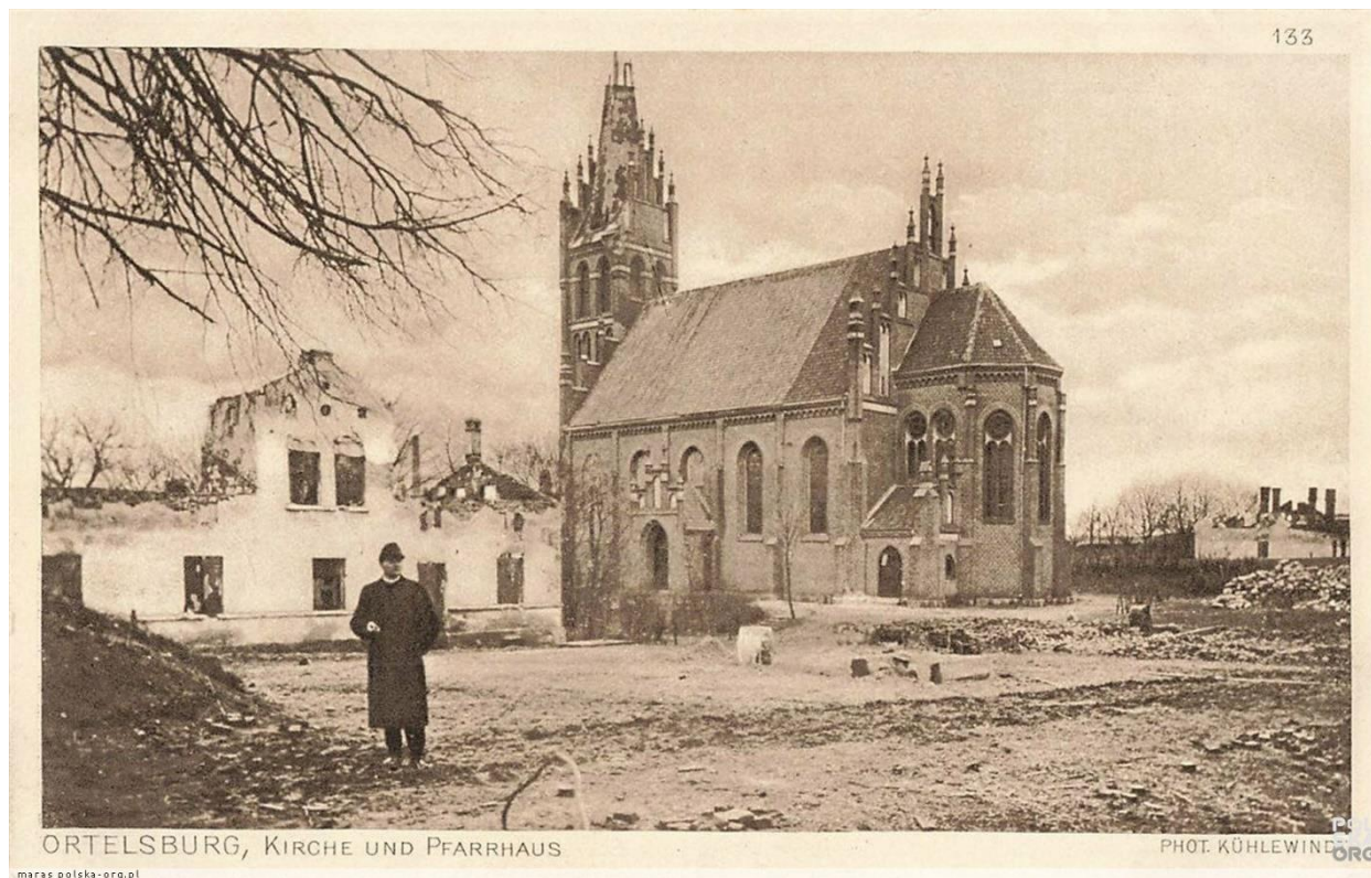
Widok uszkodzeń od strony prezbiterium. (za:polska.org)
