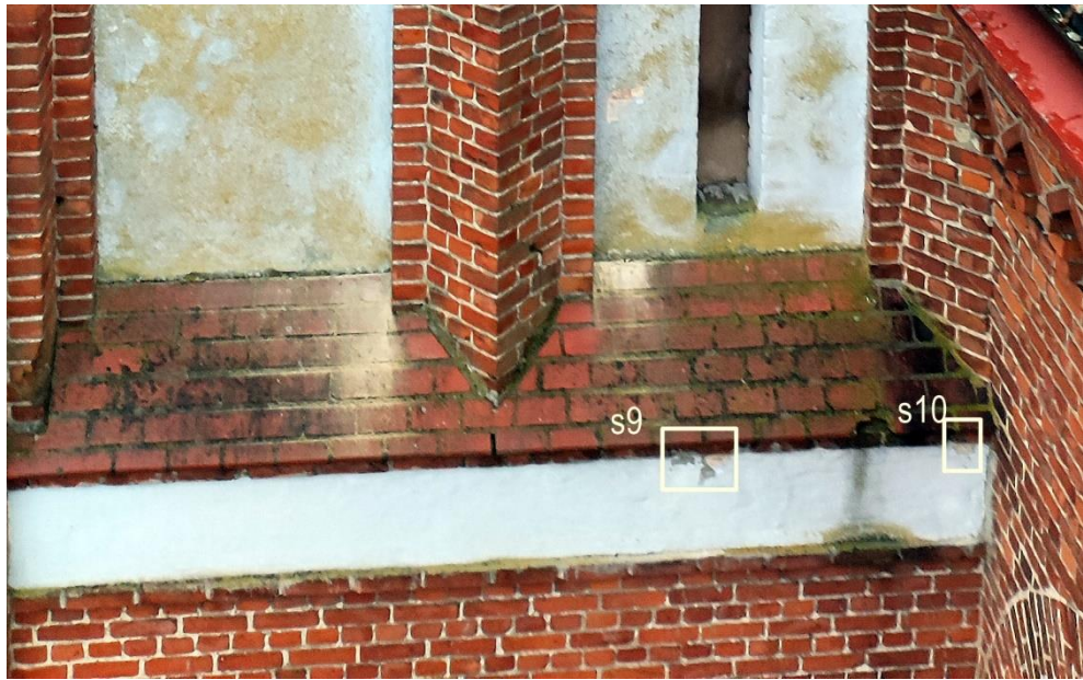
Widok lokalizacji odkrywek s9 i s10- fryz
