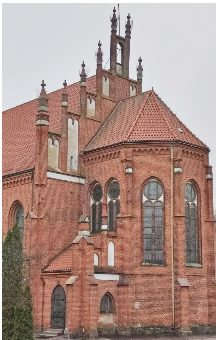
Widok ogólny ściany szczytowej oraz zbliżenie partii powyżej dachu od strony połaci.
