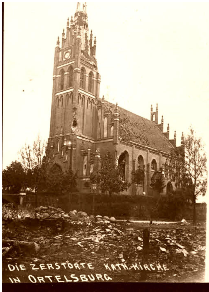
1) Zerstörte katholische Kirche in Ortelsburg
