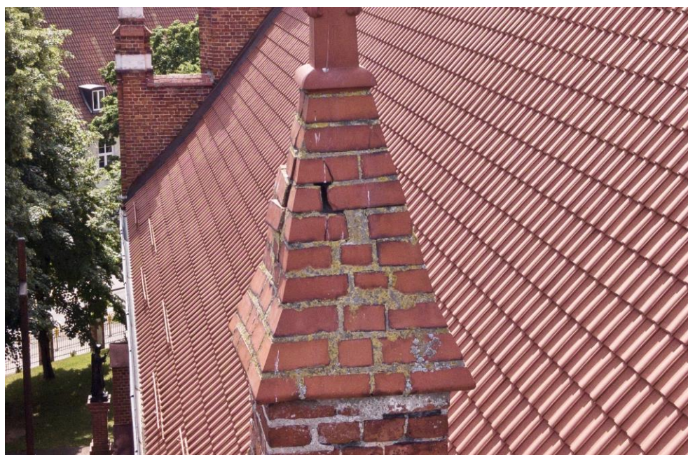
Widok sterczyn, zbliżenie fragmentu zdeformowanego.
