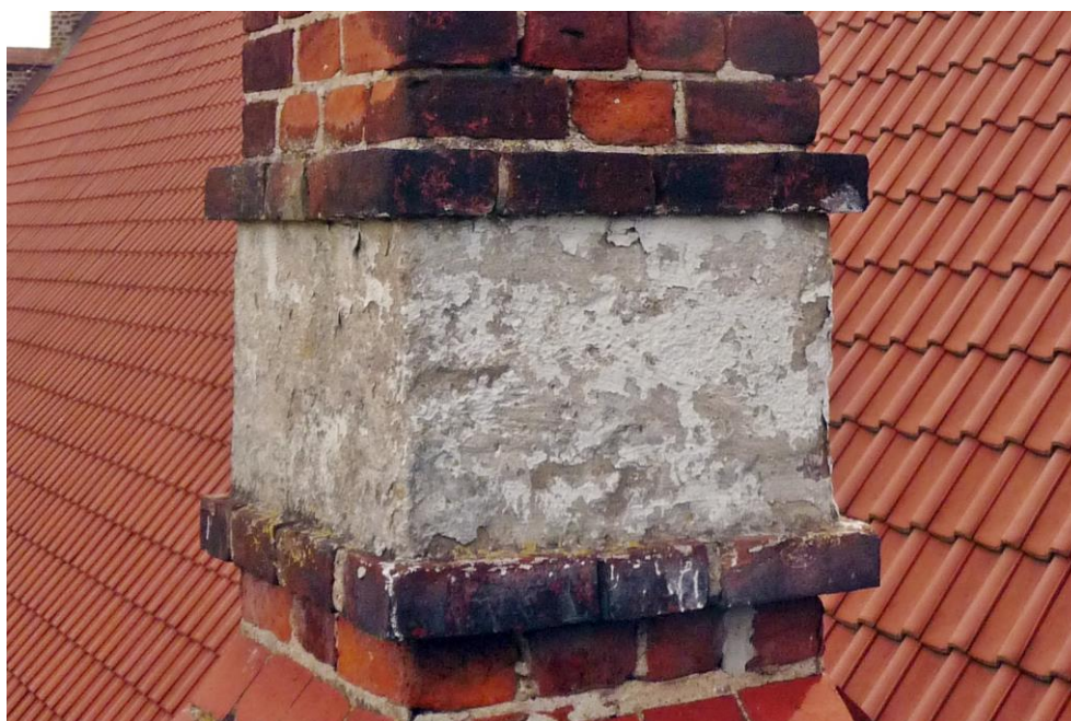
Widok fragmentu szczytu, prawdopodobne naprawy źle wykonane.
