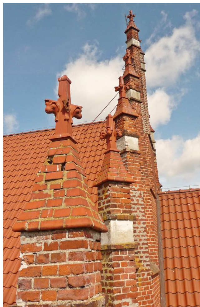
Widok fragmentu szczytu, prawdopodobne naprawy źle wykonane.
