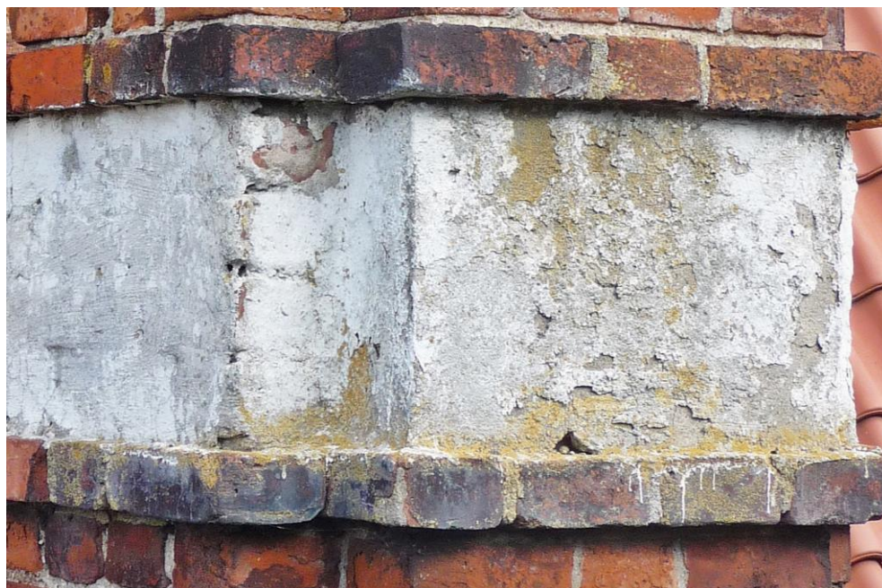
Widok sterczyny oraz zbliżenie wtórnego tynku.
