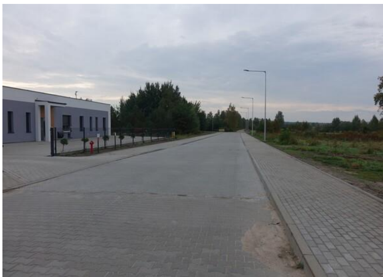
Zmodernizowana ulica Łomżyńska w Szczytnie
