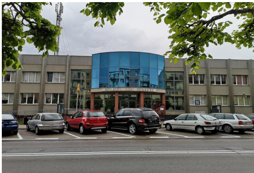
Miejski Dom Kultury w Szczecinie Źródło: Urząd Miejski w Szczecinie
