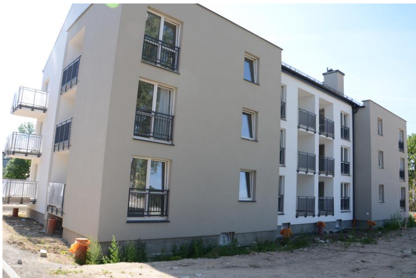
Wyremontowany blok komunalny w Szczytnie
