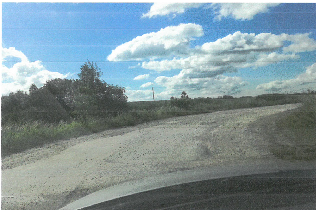
Zdj. nr 3 Km 0+077 koniec odcinka projektowanego
