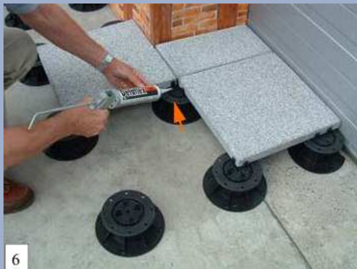
12. Po wypoziomowaniu wsporników kładziemy następną płytę.
